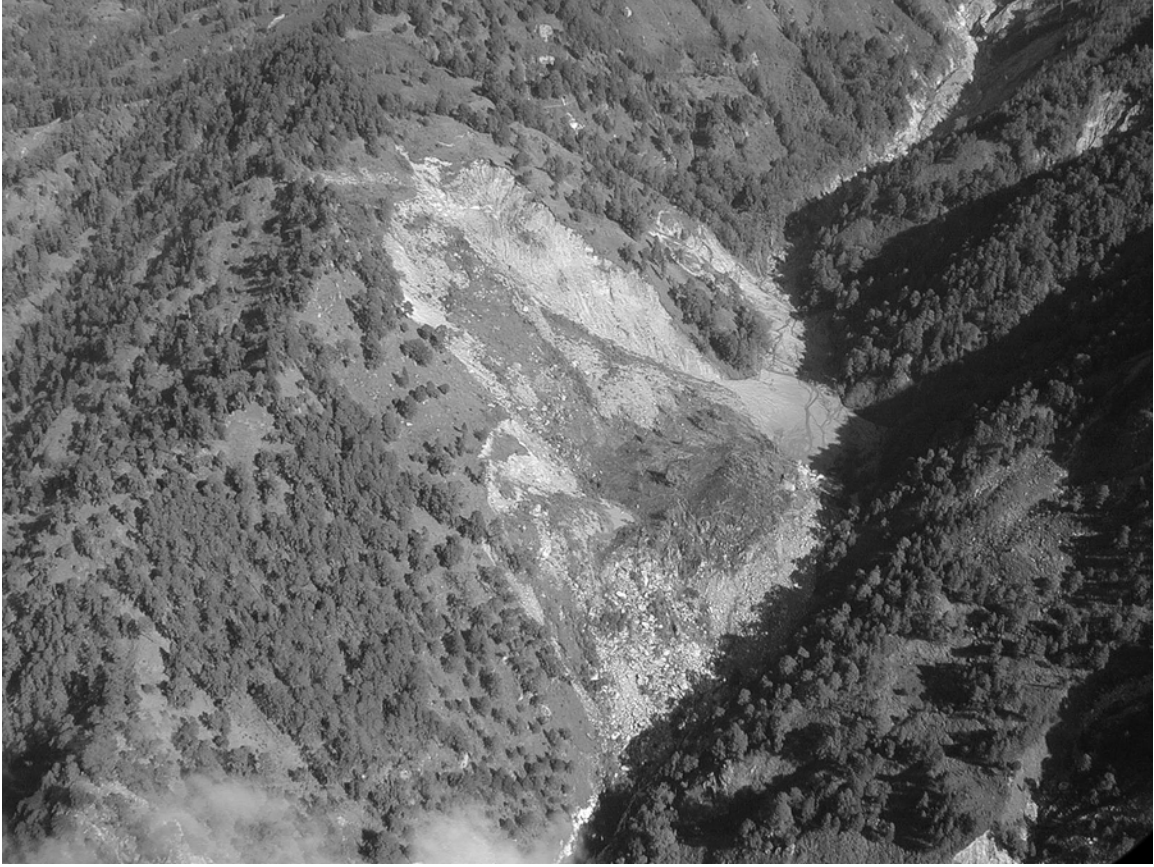
Fig. 4 Vista oblicua aérea del norte del deslizamiento de tierra que produjo el dique en el Río La Lima, 12 de enero del 2001. Superficie lisa y de color parejo cruzada por el Río La Lima en la base del deslizamiento de tierra en el relleno de sedimento detrás del dique de deslizamiento de tierra. Fotografía por Jeffrey Coe.
