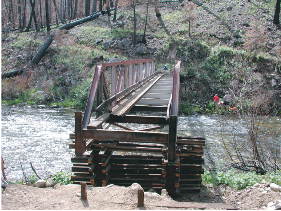
Site 01SA250-3, Pistol Creek pack bridge.
