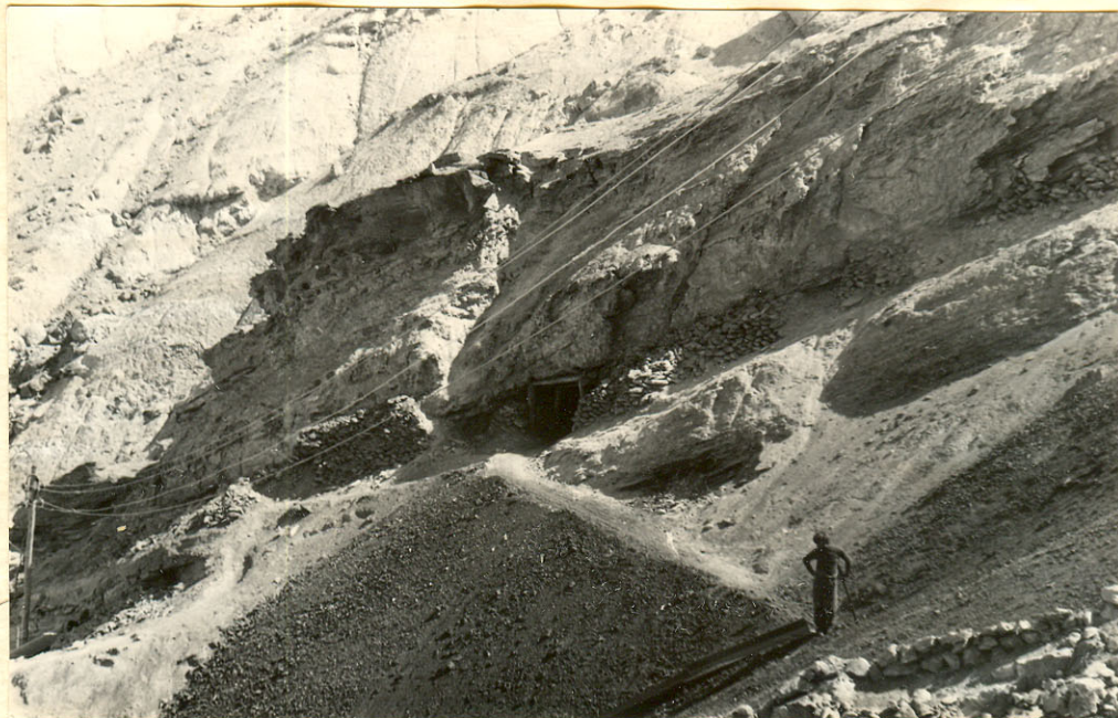
Фото № 7. Одна из эксплуатационных штолен на месторождении Гули-Санг.
