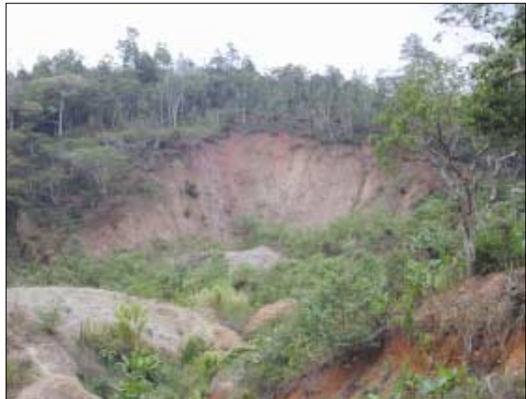
Figura 9. Grieta frontal (de unos 8 m de altura) de un desprendimiento de tierra en materiales muy meteorizado, en el norte del área de estudio de Matagalpa.
