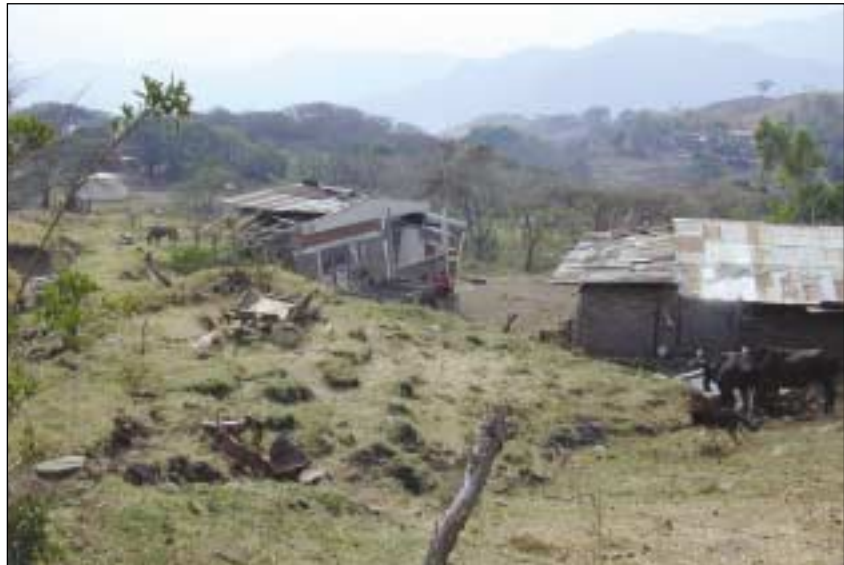
Figure 10. Punta del flujo de tierra en San Simón de Paicila. El movimiento del flujo de tierra destruyó la casa que está a la izquierda. Un lóbulo activo del flujo de tierra choca con la casa que está a la derecha.
